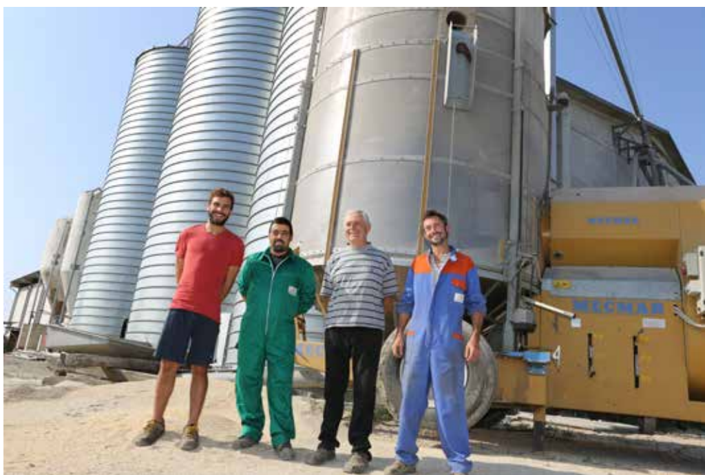
L'azienda è dotata di una batteria di silos per lo stoccaggio del mais in granella prodotto in azienda
